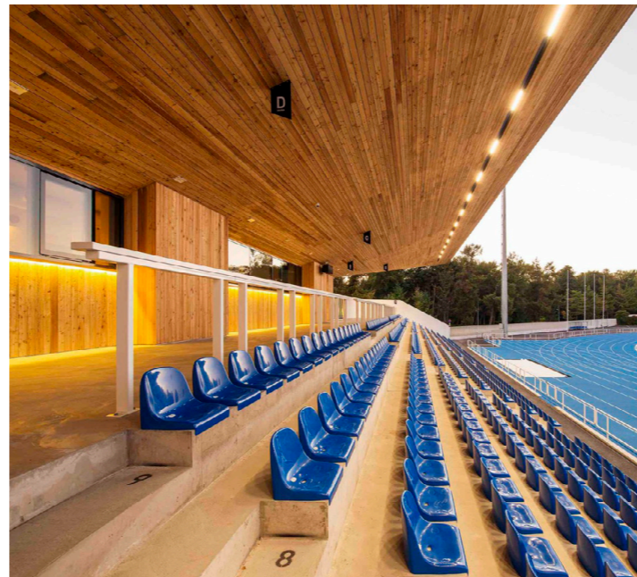
Pärnu Rannastaadion, Pärnu, Kamp Arhitektid, kuva: Terje Ugandi, www.archdaily.com (kuva rajattu esitykseen)
